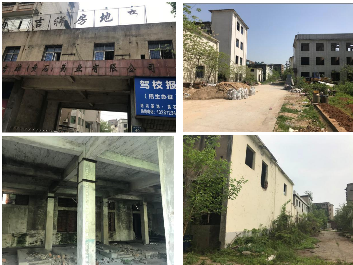
图 2.2-3 2018 年吉雄药业现场踏勘情况
